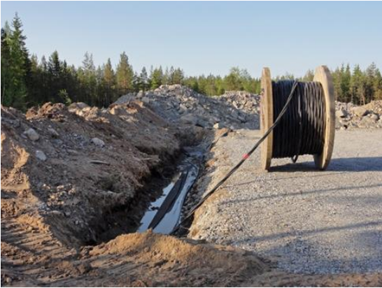
Kuva 20. Maakaapelit upotetaan huoltoteiden yhteyteen (Kuvat: FCG).
