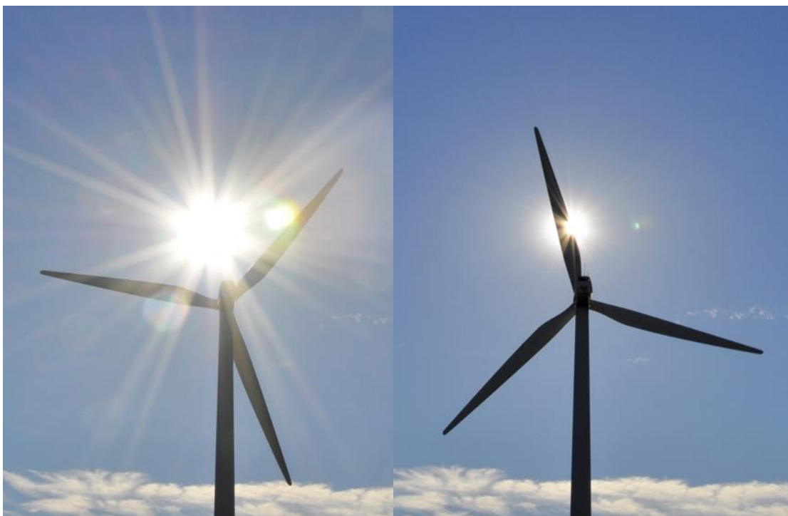
Kuva 97. Tuulivoimaloiden lavat aiheuttavat pyöriessään vilkkumista ja varjon välkkymistä aurinkoisella säällä.
