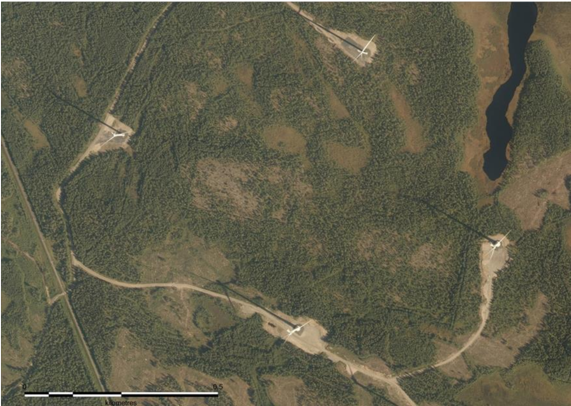
Kuva 9. Esimerkkikuva toiminnassa olevasta tuulivoima-alueesta. Tuulivoimaloita varten on rakennettu huoltotiet ja nostokentät. Tuulivoimaloiden ympäristössä ja välialueilla aikaisempi maankäyttö on säilynyt ennallaan.
