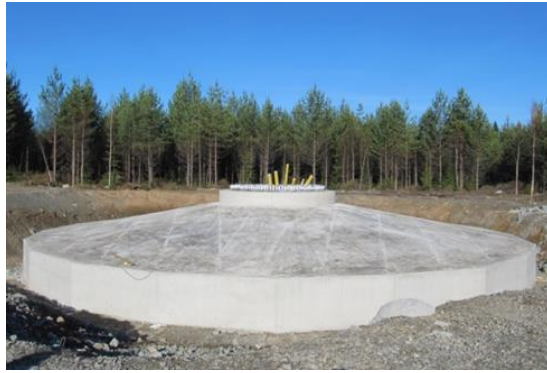
Kuva 21. Tuulivoimalan perustusten rakentamista (Kuvat: FCG).
