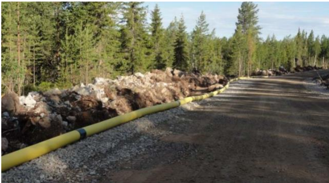
Kuva 47. Vasemmalla on esimerkki tuulivoimapuiston rakennus- ja huoltotiestä. Teitä käytetään muun muassa betonin, soran ja voimaloiden komponenttien kuljetuksiin sekä tuulivoimapuiston käyttövaiheessa huoltoajoihin. Maakaapeli sijoitetaan ojakaivantoon tien reuna-alueelle. (Ville Suorsa, FCG)
