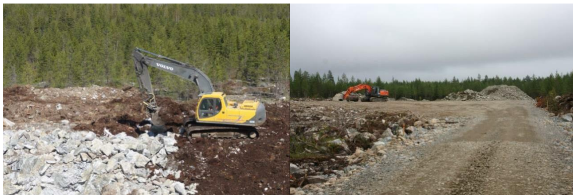
Kuva 48. Huoltoteiden ja pystytysalueiden rakentamista (Ville Suorsa, FCG)
