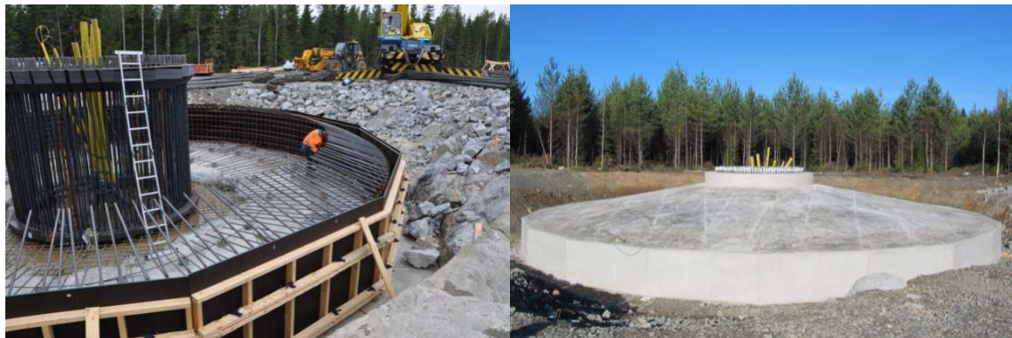
Kuva 51. Tuulivoimalan perustusten rakentamista (Leila Väyrynen, FCG)
