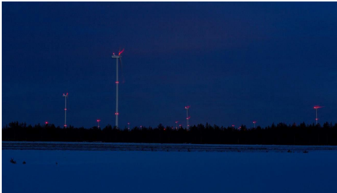
Kuva 44. Kiinteät punaiset lentoestevalot (Ville Suorsa, FCG)
