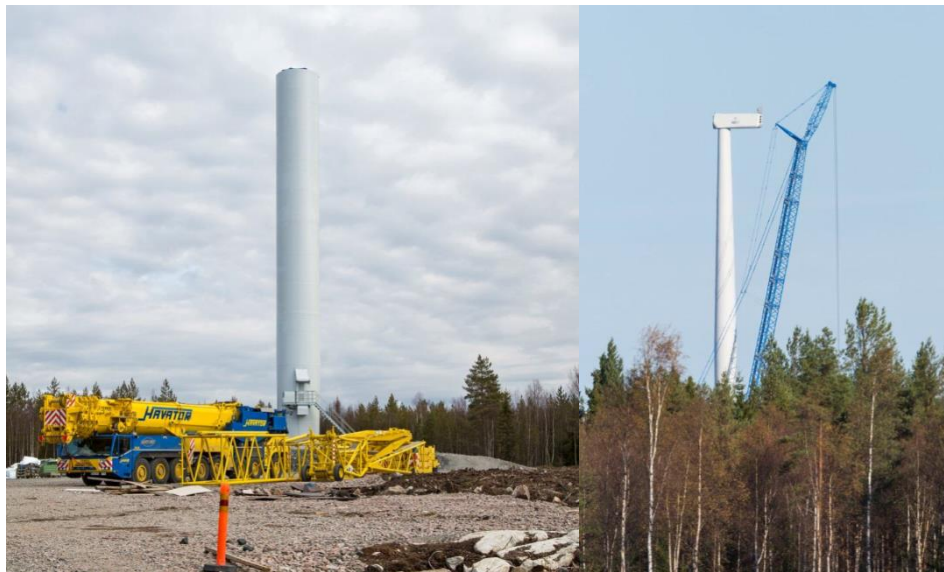
Kuva 52. Voimaloiden kokoamista (Ville Suorsa, FCG)
