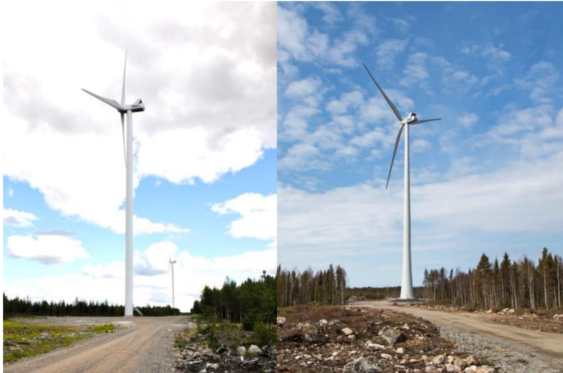
Kuva 42. Vasemmalla on esimerkki teräslieriötornista ja oikealla hybriditornista. (Leila Väyrynen ja Ville Suorsa, FCG)
