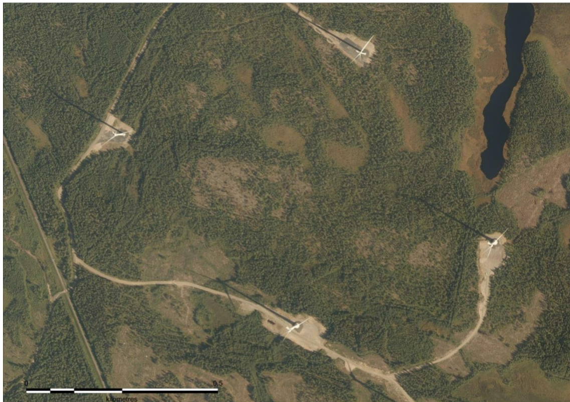
Kuva 41. Ilmakuvassa näkyy toiminnassa olevia tuulivoimaloita. Tuulivoimaloita varten on rakennettu huoltotiet ja nostokentät. Tuulivoimaloiden ympäristössä ja välialueilla aikaisempi maankäyttö on säilynyt ennallaan. Kuva ei ole Paholammin alueelta.
