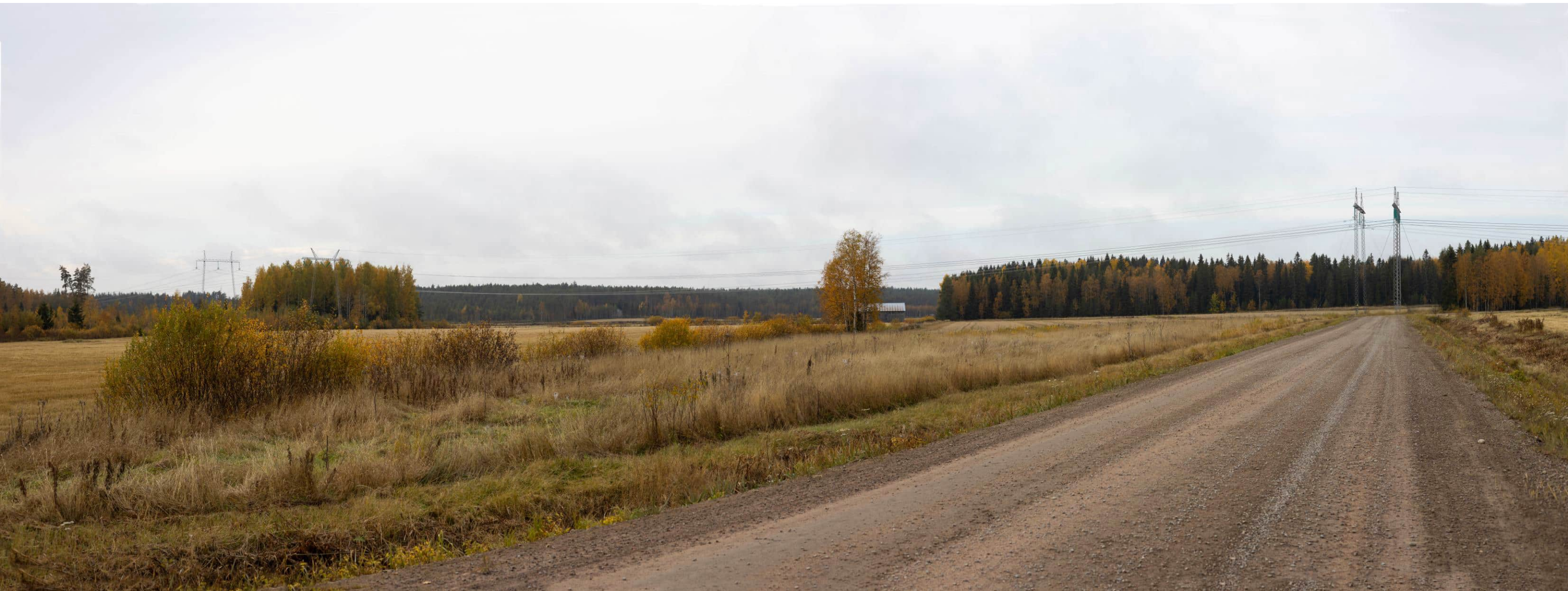
Kuva 69. Voimajohdon havainnekuva (läheltä) Mämmintieltä kuvauspisteestä 2. Sähkönsiirron reittivaihtoehto A ja B kauempana kuvassa.
